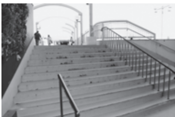
スロープのないメイン連絡橋
