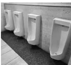
ひとつも手すりが無い市民ホールの小便秘器
