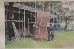
高倉庫 調査解体 大戸の解体状況 (10区)
