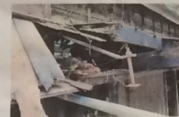
高倉庫 調査解体 大戸の解体状況 (10区)
