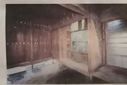
高倉庫 調査解体 内部の柱梁 (10区)
