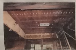
高倉庫 調査解体 内部の柱梁 (10区)
