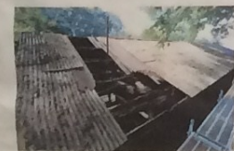
高倉庫 調査解体 大戸の解体状況 (10区)
