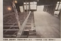
高倉庫 調査解体 内部の柱梁 (10区)
