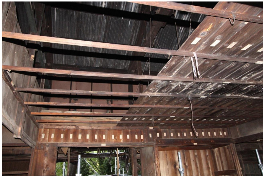
車庫棟 調査解体 天井部材取外し状況（C室）
