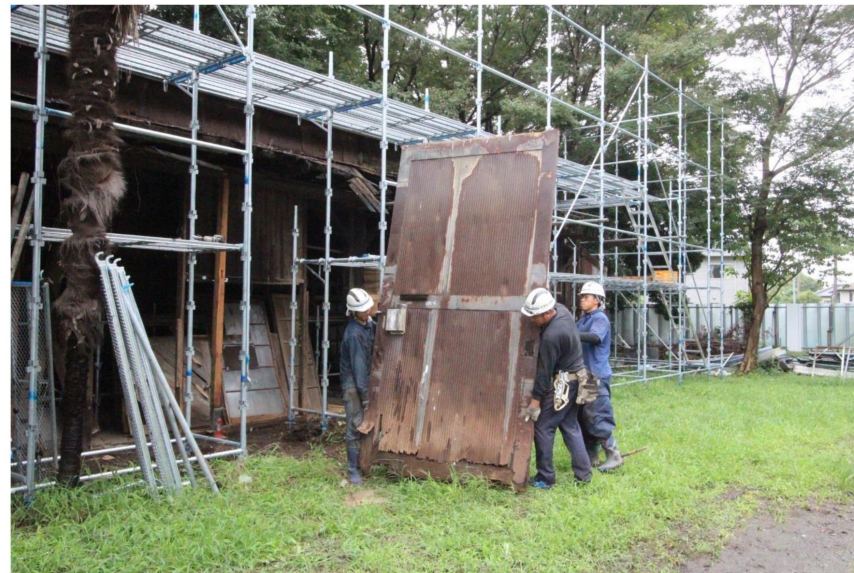
車庫棟 調査解体 大戸の取外し状況
