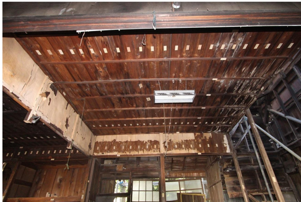
車庫棟 調査解体 解体番付札の取付け状況（C室天井部分）
