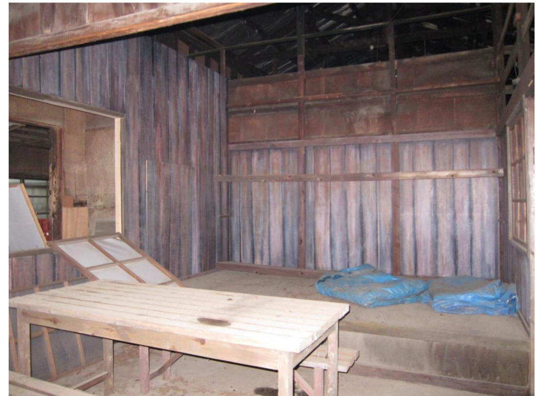
守衛棟 調査解体 内部の状況（E・F室）
