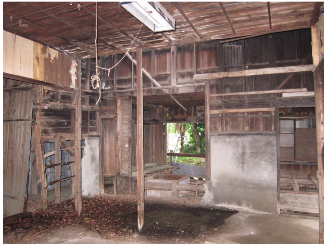
車庫棟 調査解体 内部の状況（C室）
