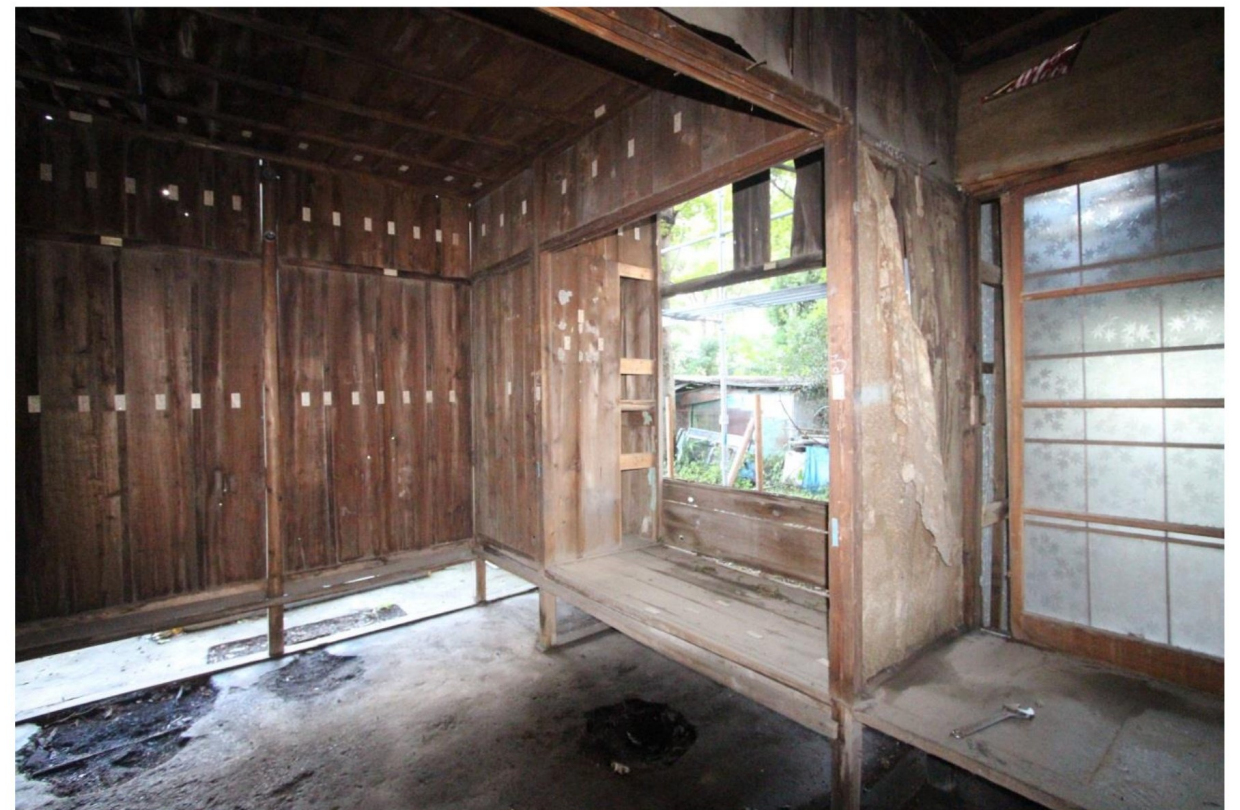
車庫棟 調査解体 内部後補材撤去・解体番付札取付け状況（E・F室）
