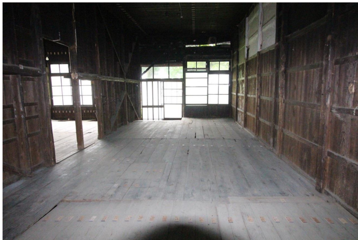
兵舎棟 調査解体 内部の状況（5号資料室〔I室〕部分）
