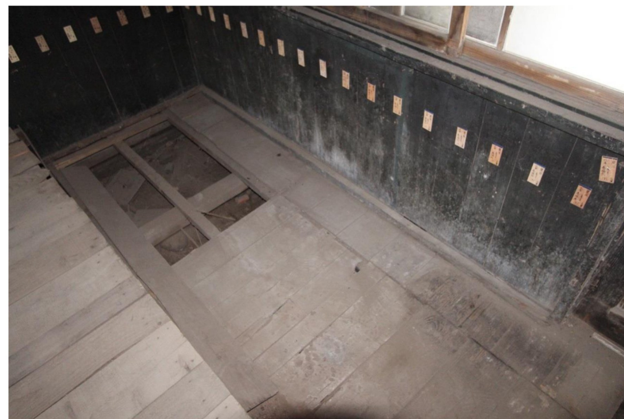
兵舎棟 調査解体 旧床板の痕跡（3号資料室〔G室〕）
