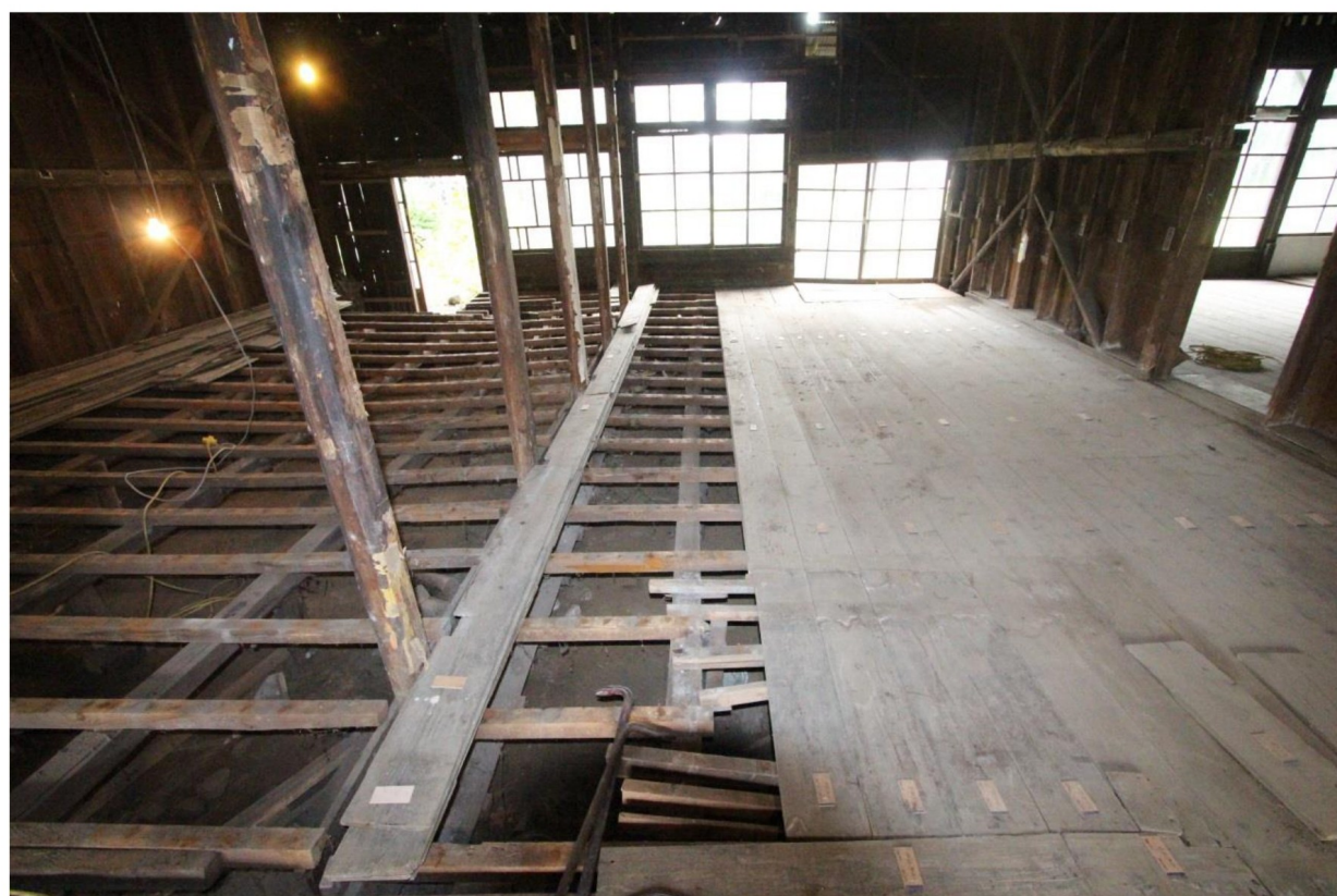
兵舎棟 調査解体 床板材の取外し状況（1号資料室〔E室〕便房部分）
