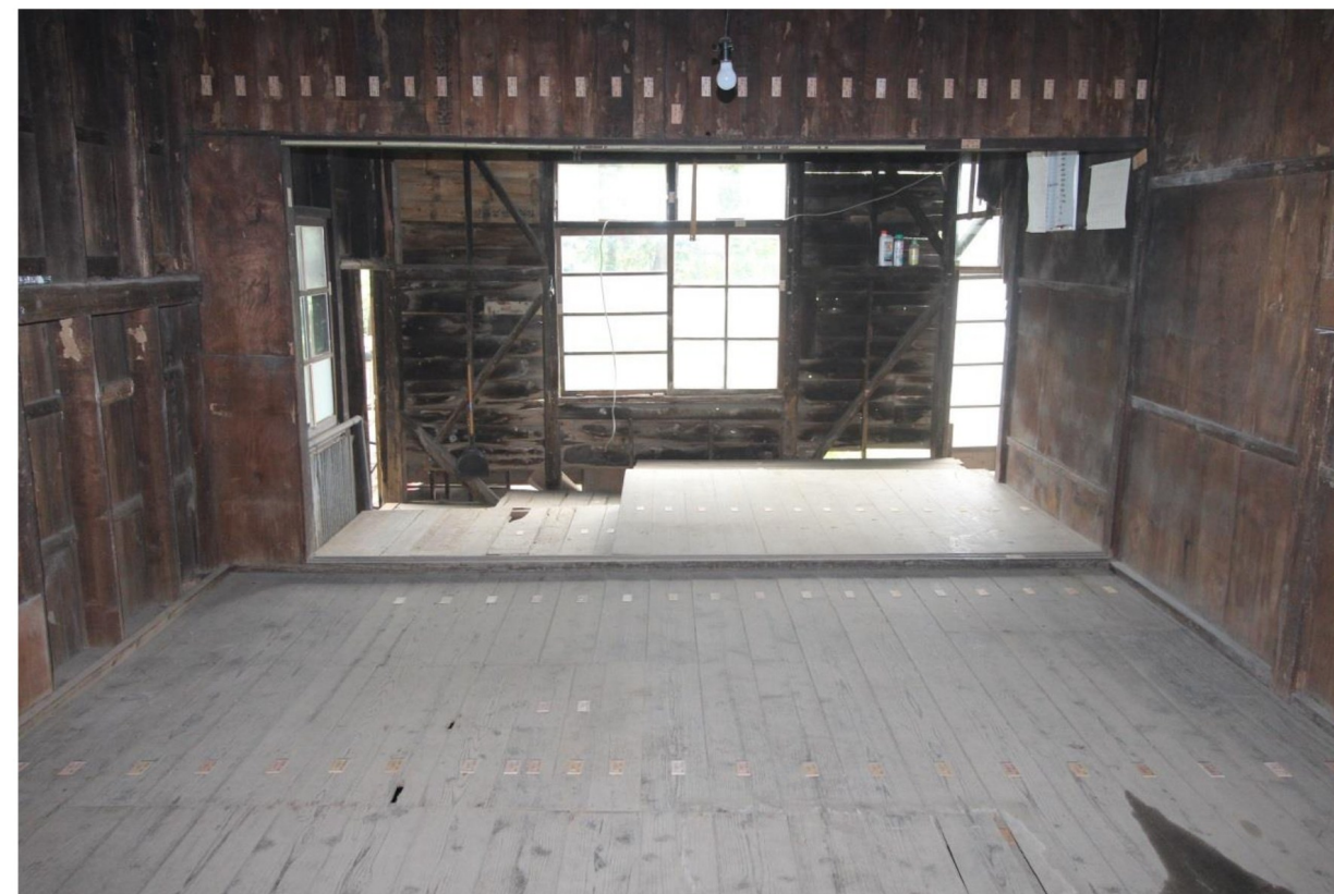
兵舎棟 調査解体 内部状況（休憩室〔D室〕部分）
