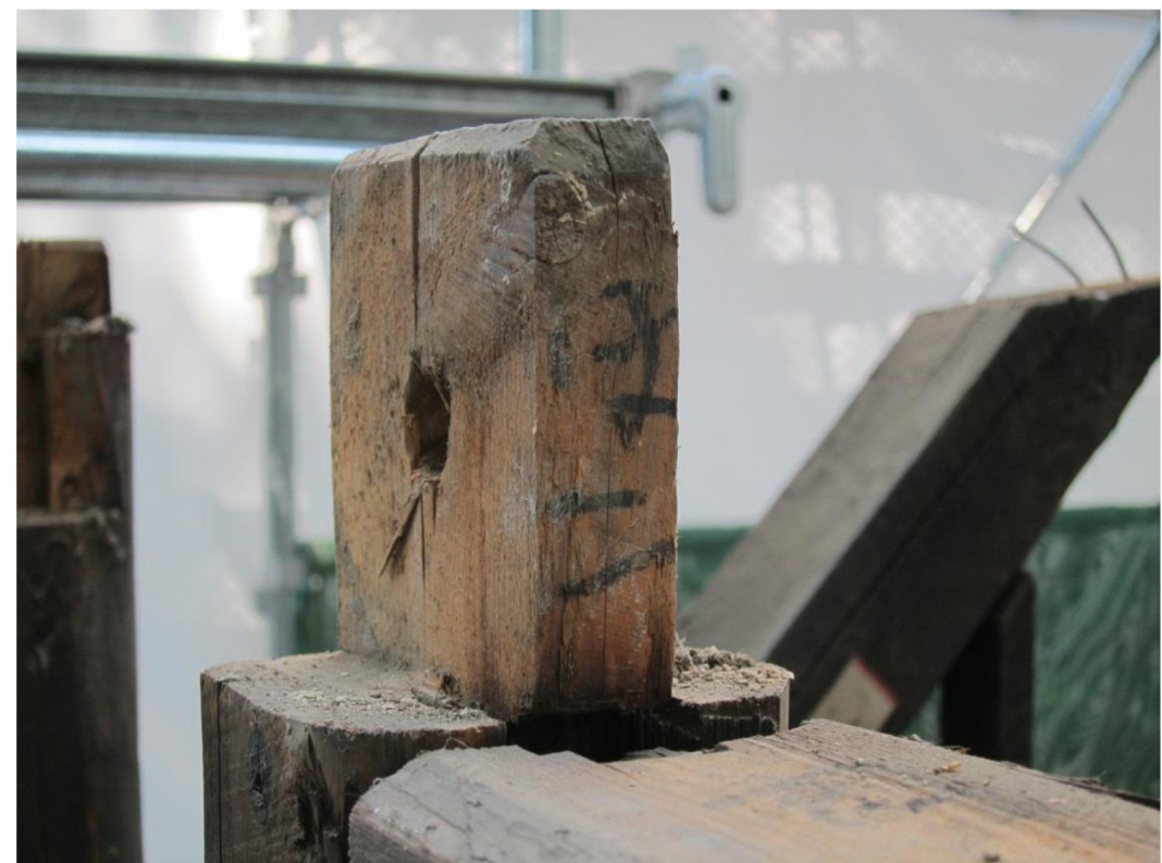
守衛棟 調査解体 柱ほぞに残る旧組立番付「ほ二」
