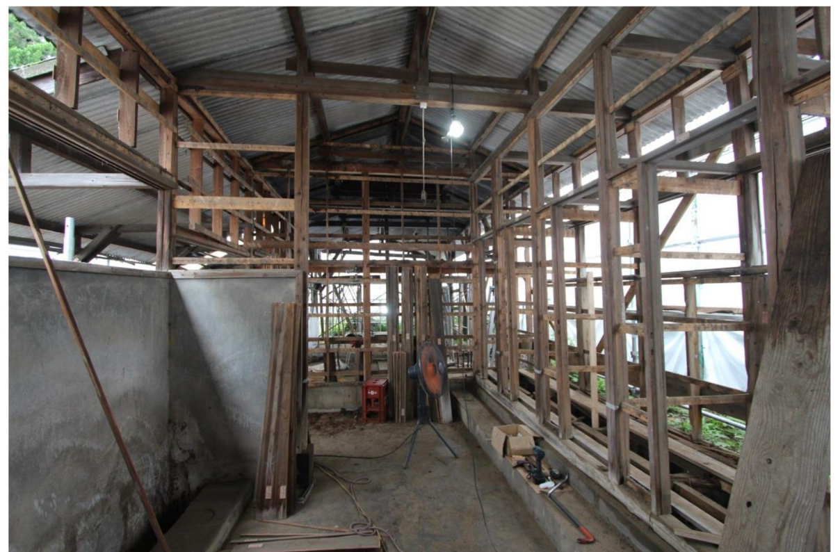
便所棟 調査解体 内壁取縦板の取外し状況（便房部分）
