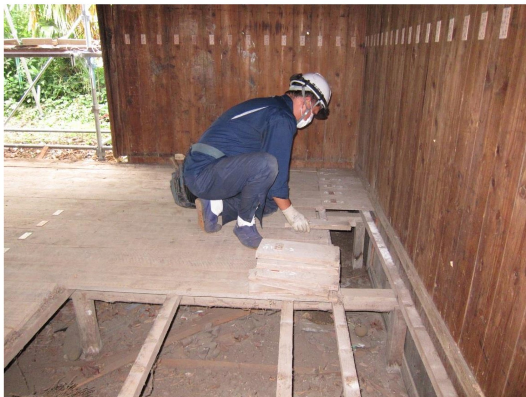
便所棟 調査解体 床部材の取外し状況（和室部分）
