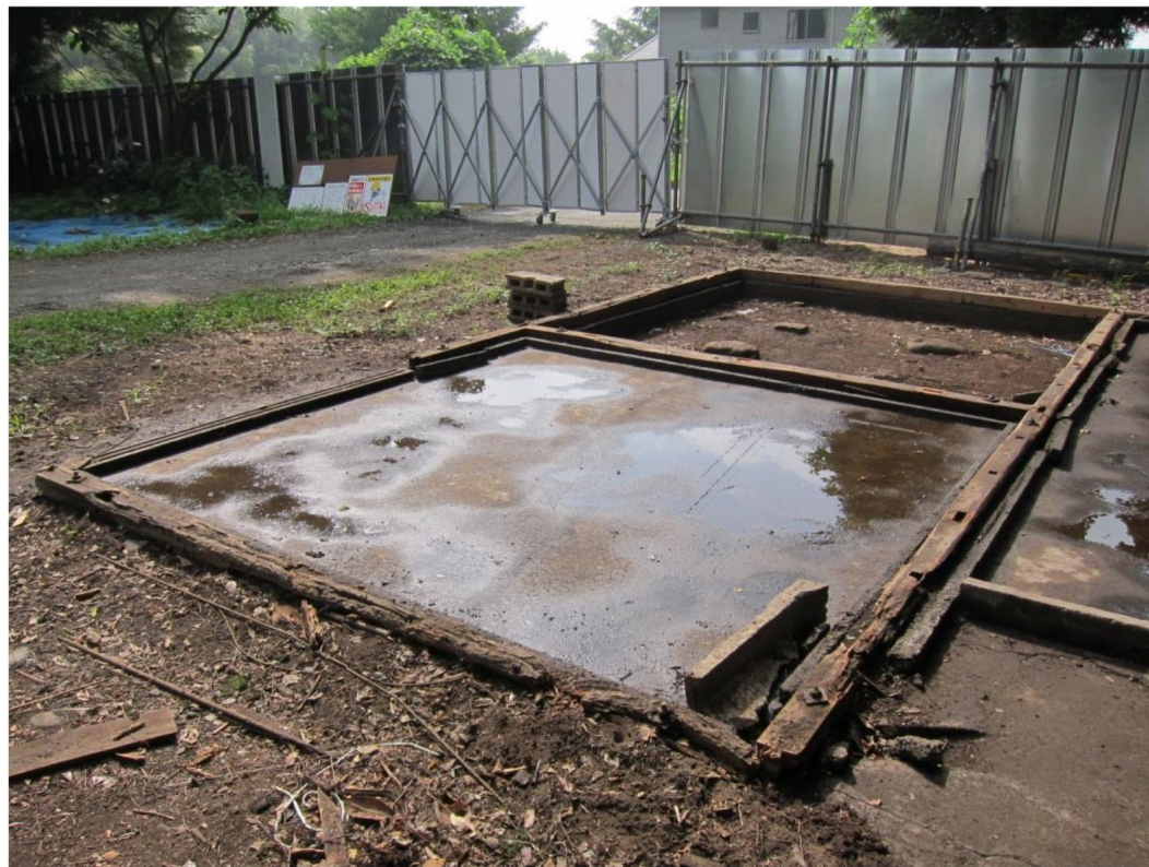
守衛棟 調査解体 軸組部材取外し完了状況（A・B室部分）
