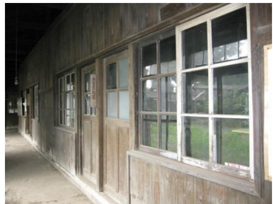
廊下に面した内部建具の状態
