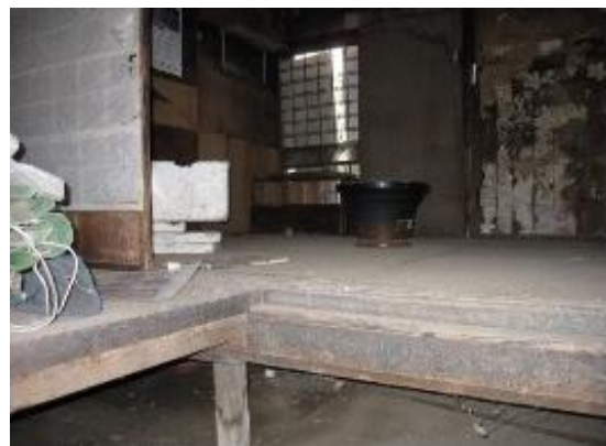
内部間仕切りなどの改変状況
