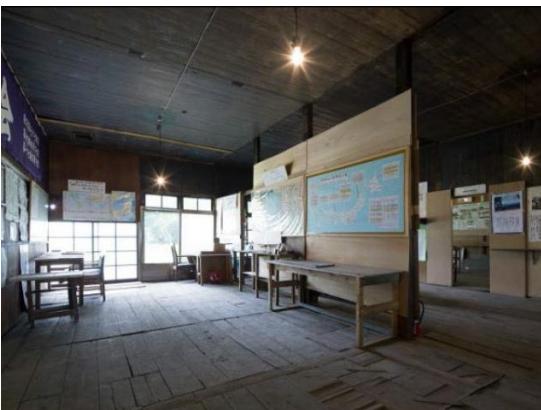
内部間仕切り・床組などの改変
