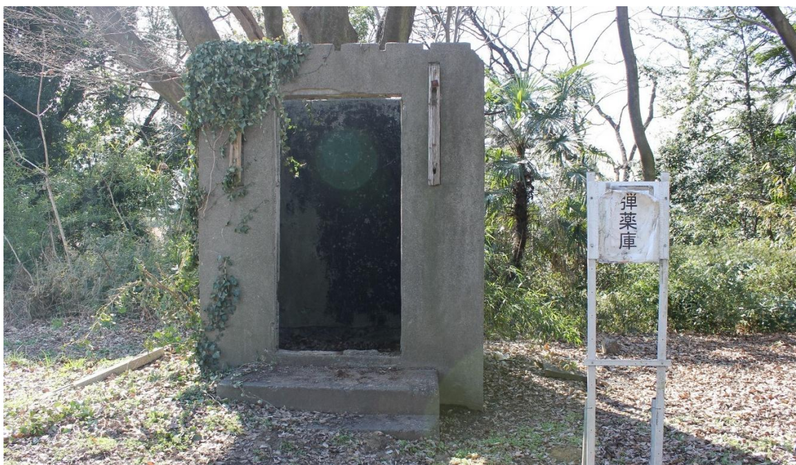
弾薬庫 建物全景
