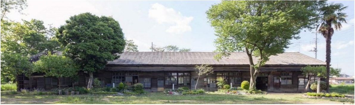
兵舎棟 建物全景
