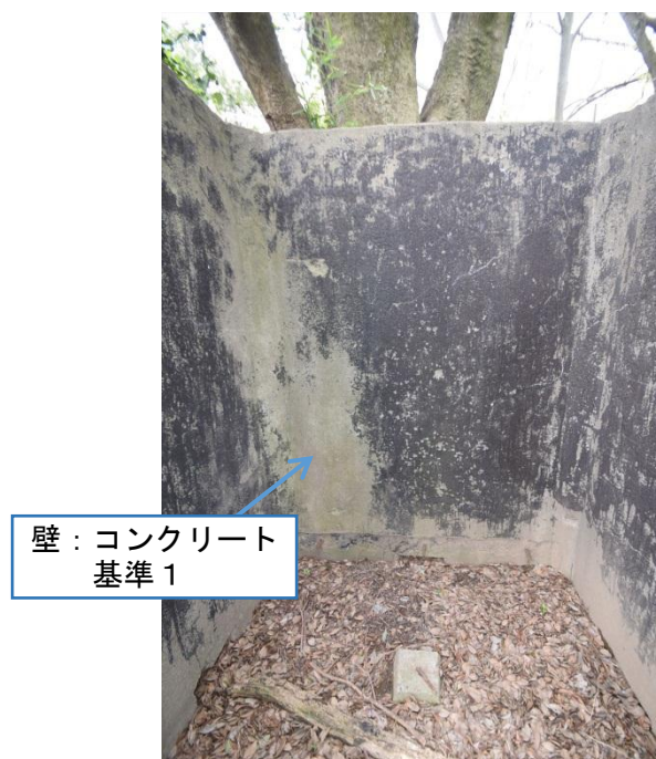
写真Ⅱ－弾1 内部
