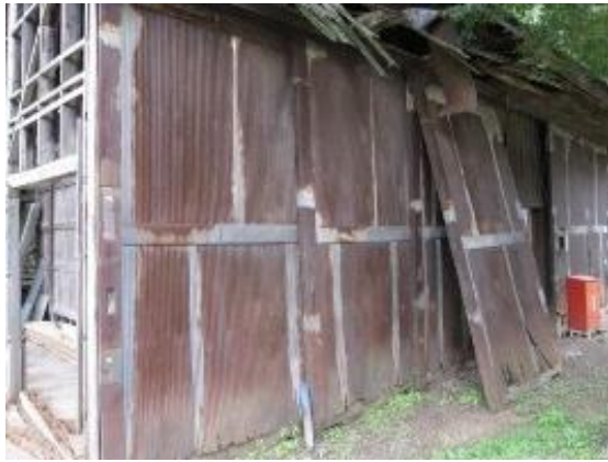
鋼製スライドゲートの劣化状況
