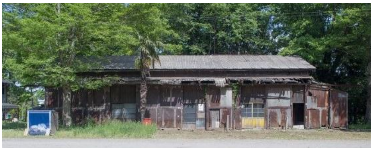
車庫棟 建物全景
