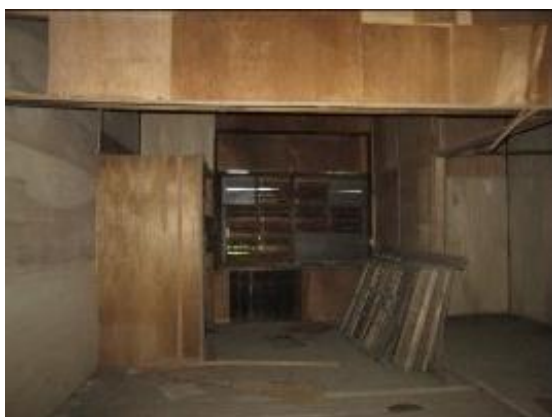
内部間仕切りの改変状況
