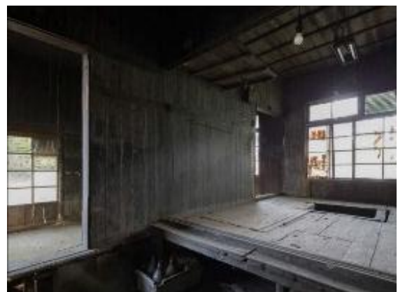
床組みの改変状況
