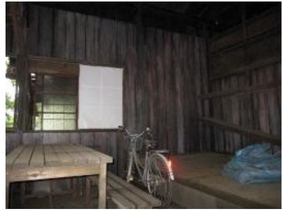
内部間仕切り・床組などの改変
