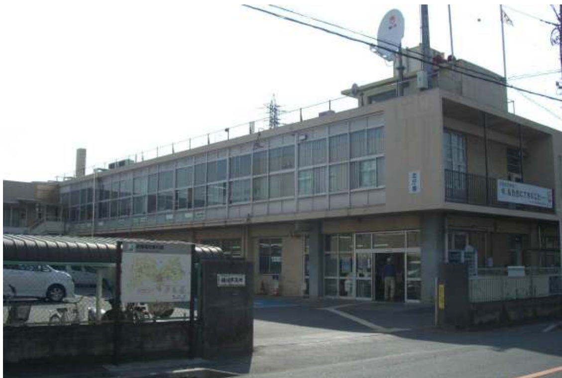
【昭和34年に建設された本庁舎（北庁舎）】
